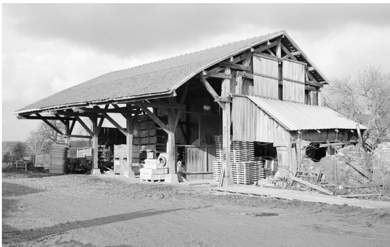
Hangar de stockage des bois à usiner.
