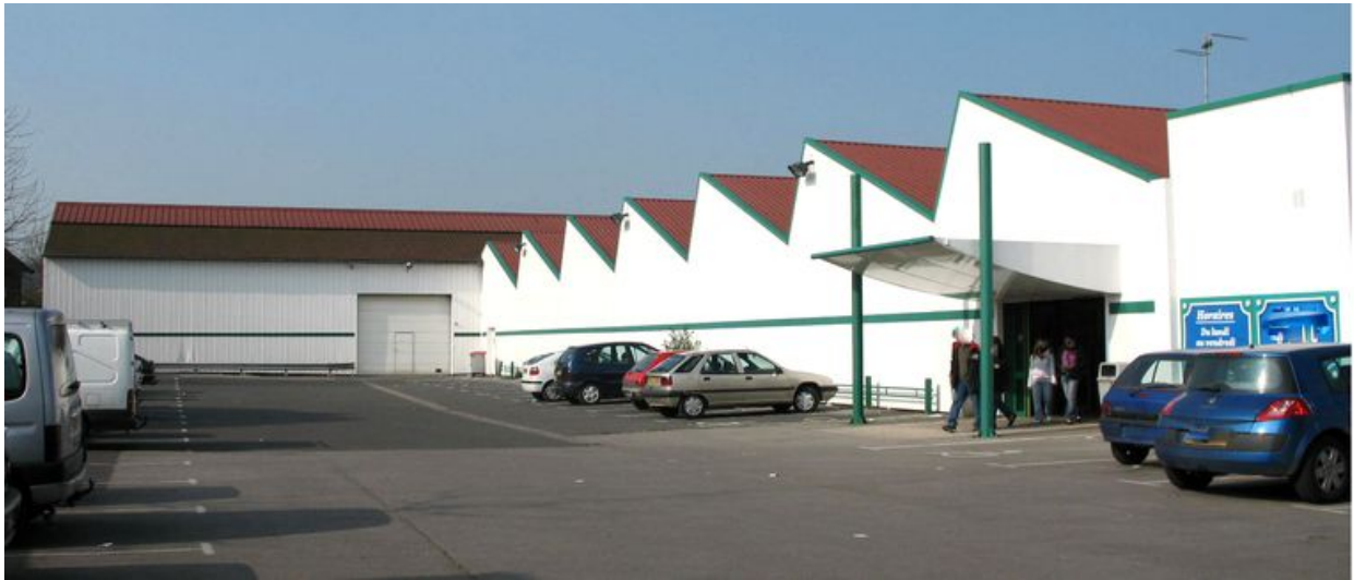
Vue générale de l'usine, façade ouest.
