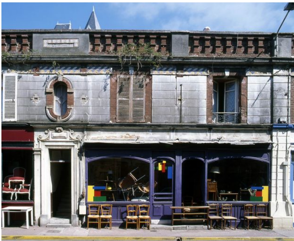
Détail d'une unité.
