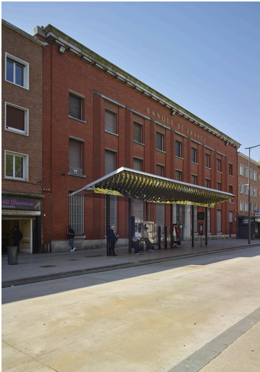
Vue générale de la façade.
