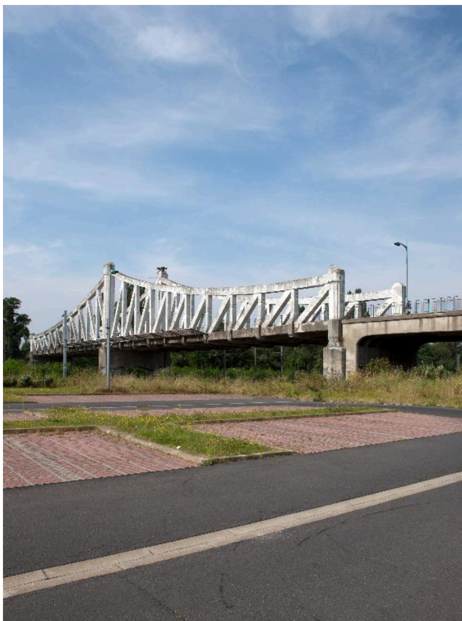
Vue générale du pont béton du chemin fer.
