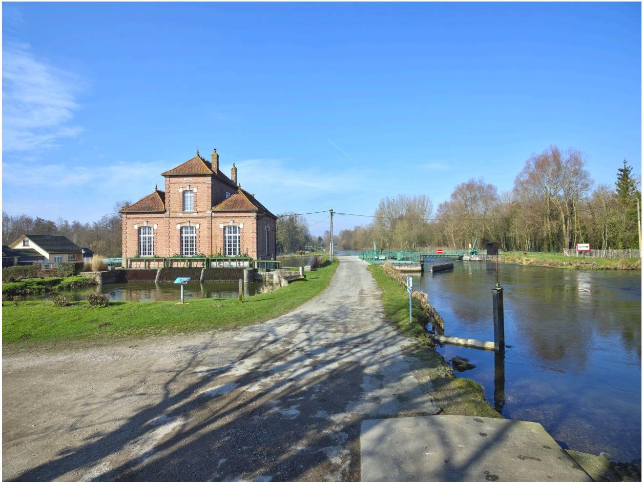
Vue de la centrale et du barrage du canal de déchargement, depuis l'ouest.
