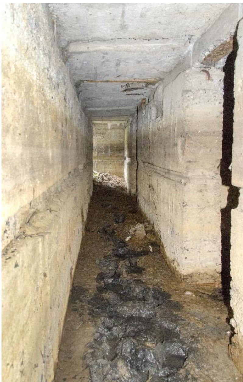
Couloir C1. Vue en enfilade vers l'ouest.
