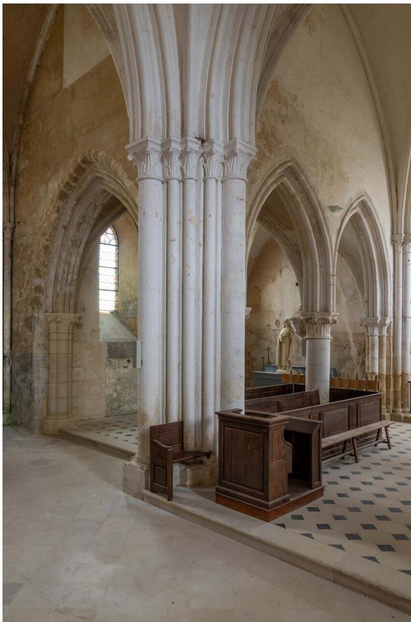
Chapelle. Croisillon nord du transept.
