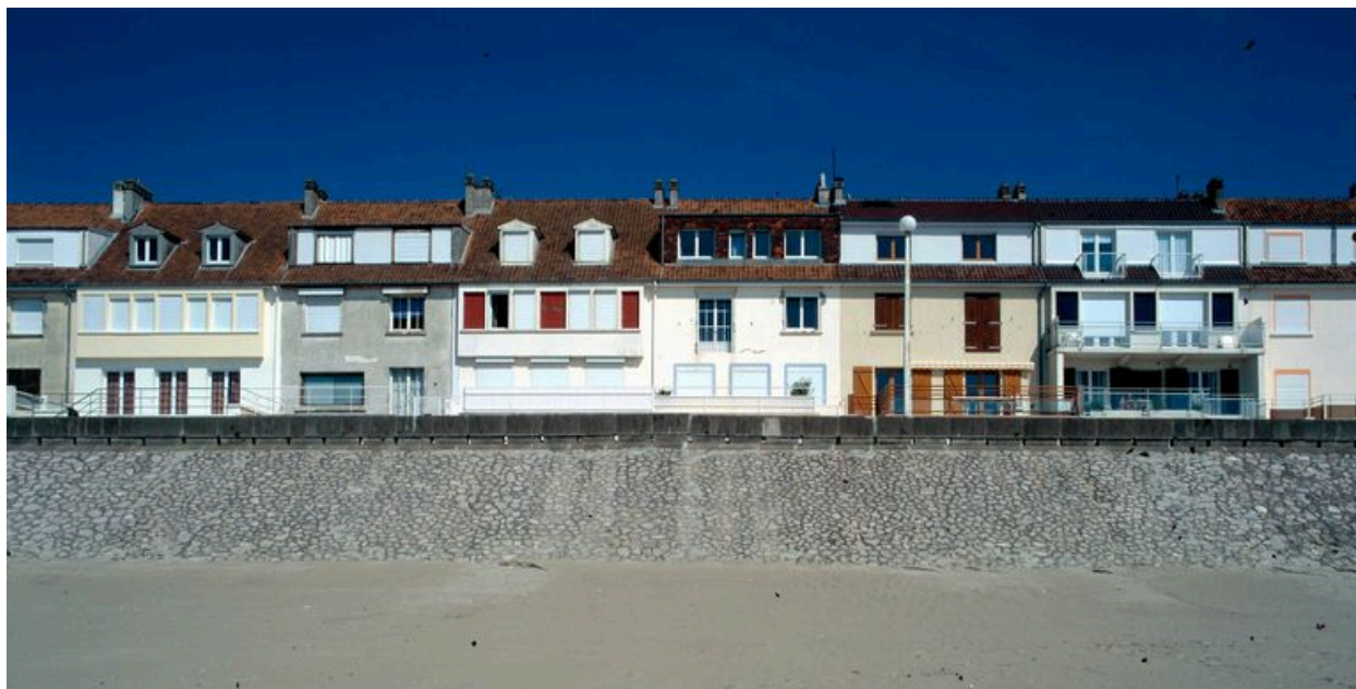
Vue de face de quelques maisons, depuis la plage.
