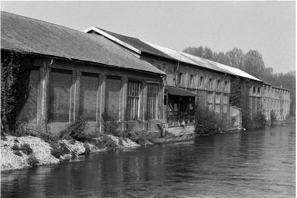
Élévation nord des ateliers et magasins industriels donnant sur la Somme.
