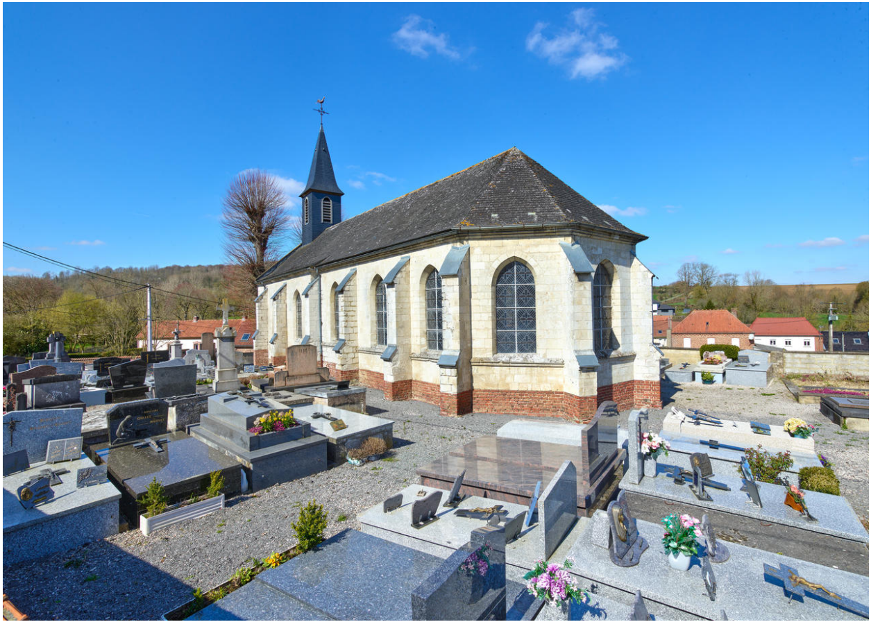
Vue du chevet depuis le sud-est.
