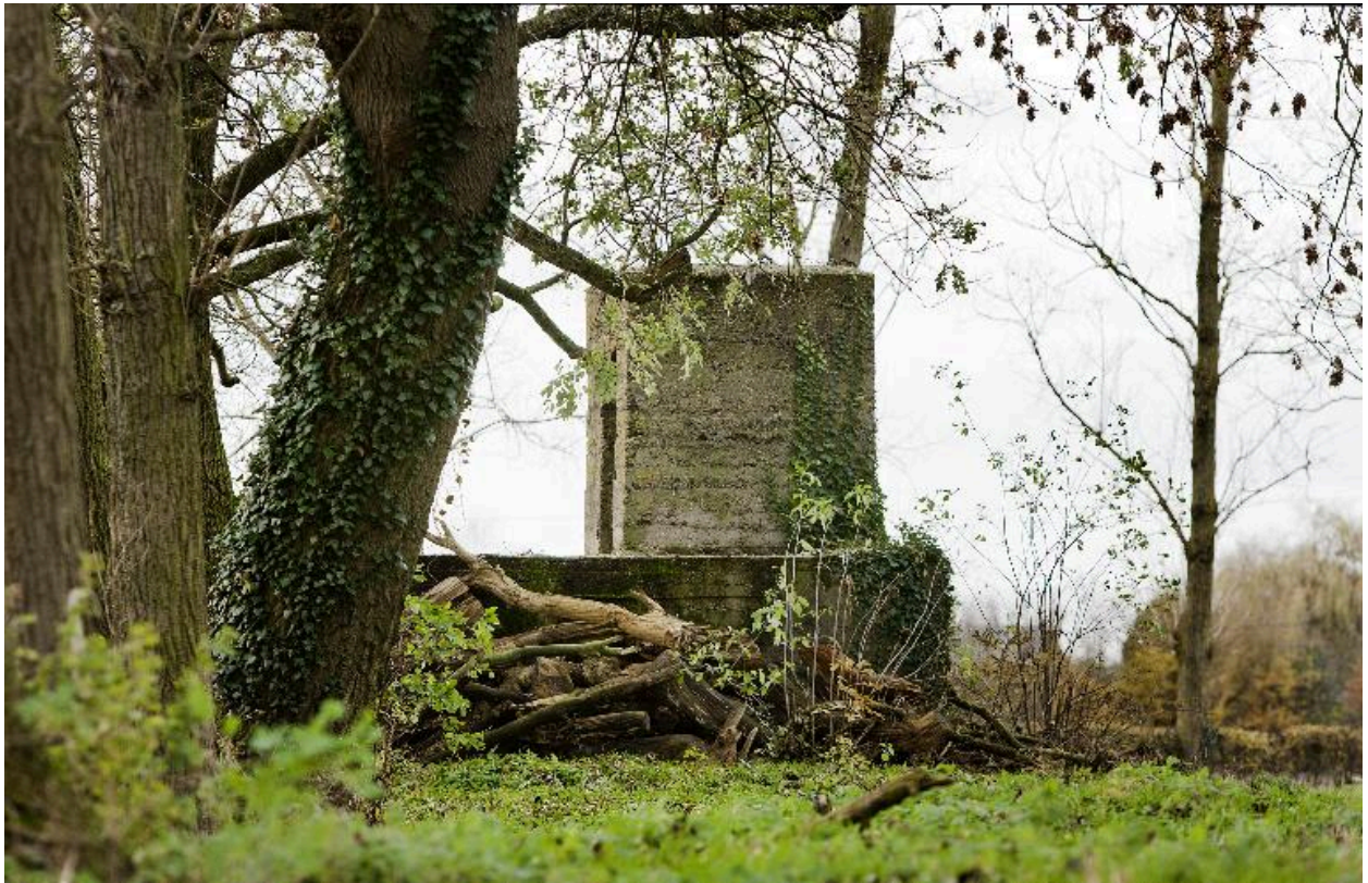
Vue partielle, vers le sud-ouest
