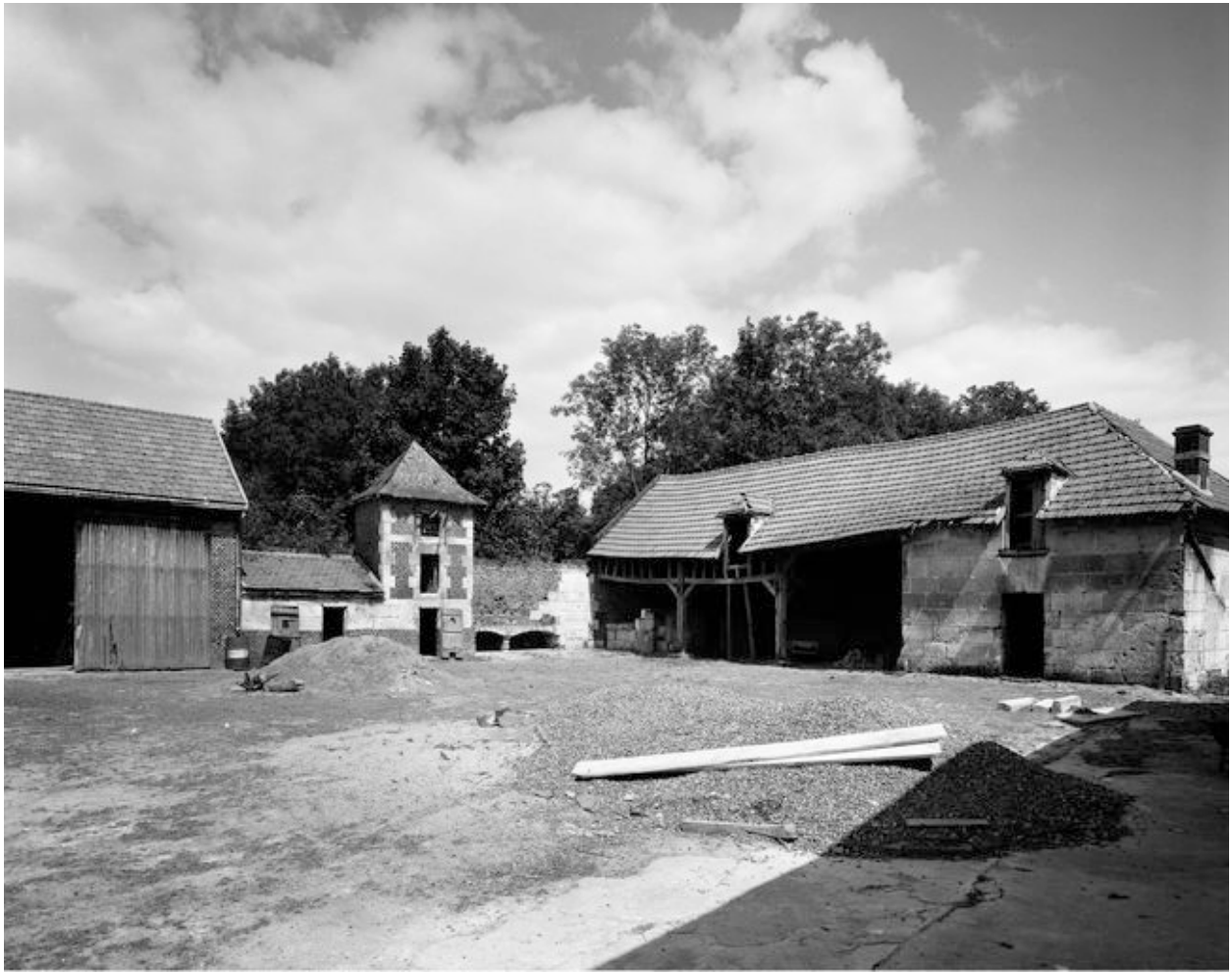
Bâtiments sur cour.
