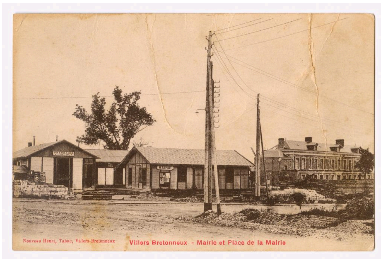
Villers-Bretonneux. Mairie et place de la Mairie. Carte postale, vers 1919 (coll. part. Drillancourt). Les constructions provisoires et l'ancienne filature Dheilly à l'arrière-plan.
