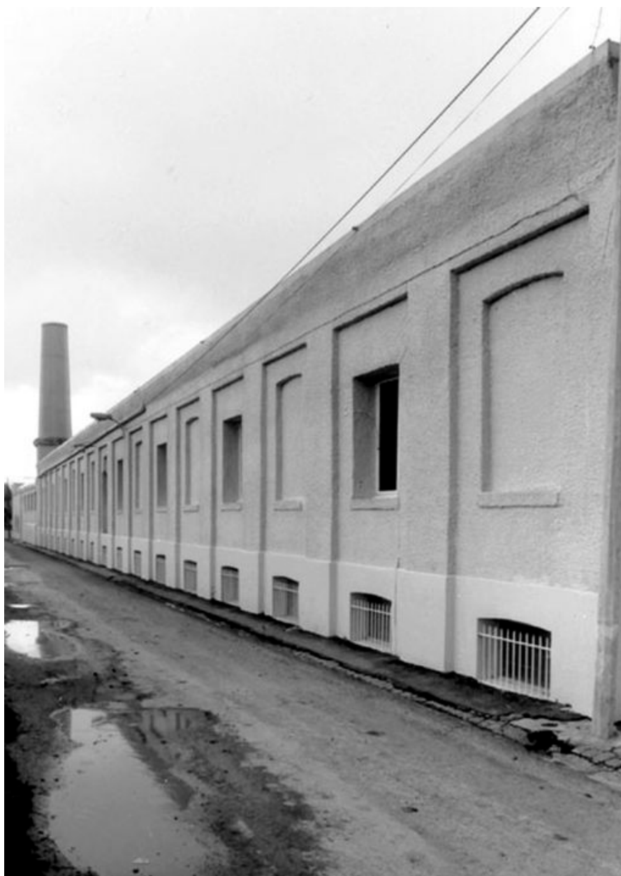
Vue partielle, élévation ouest.
