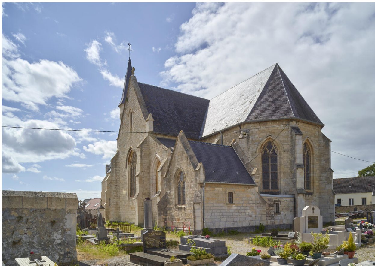
Vue du chevet depuis le sud-est.
