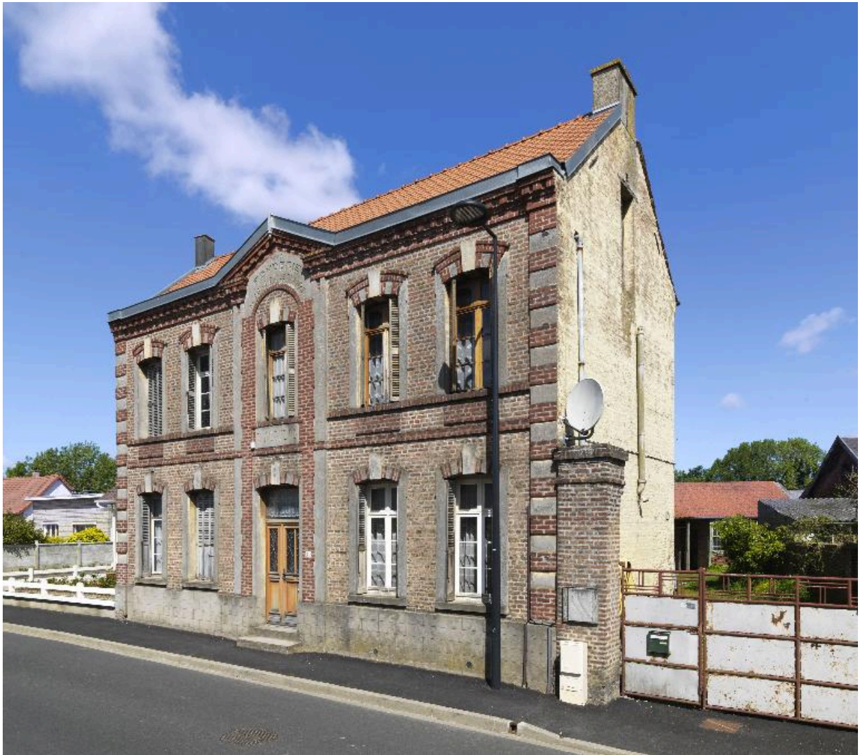
Ancien logement patronal.
