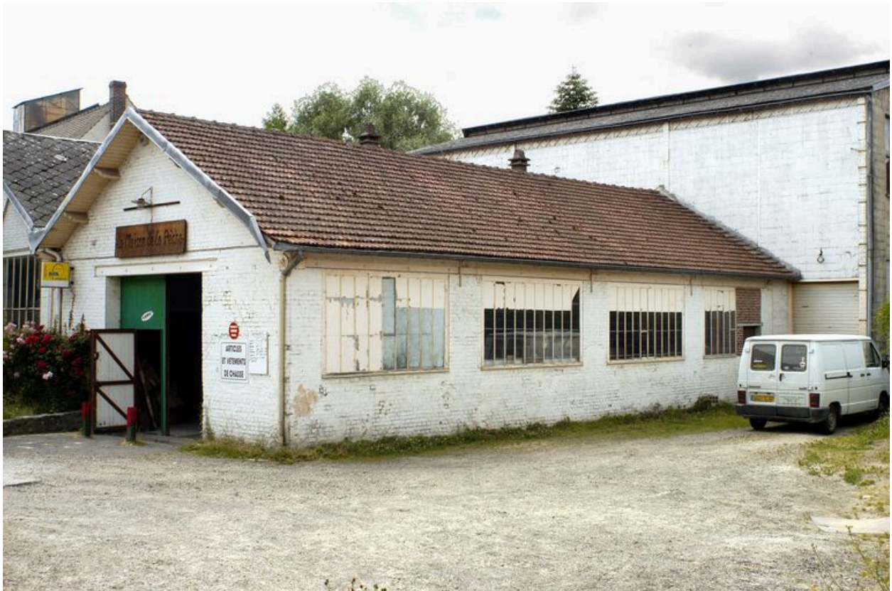
Vue d'un des atelier de fabrication.
