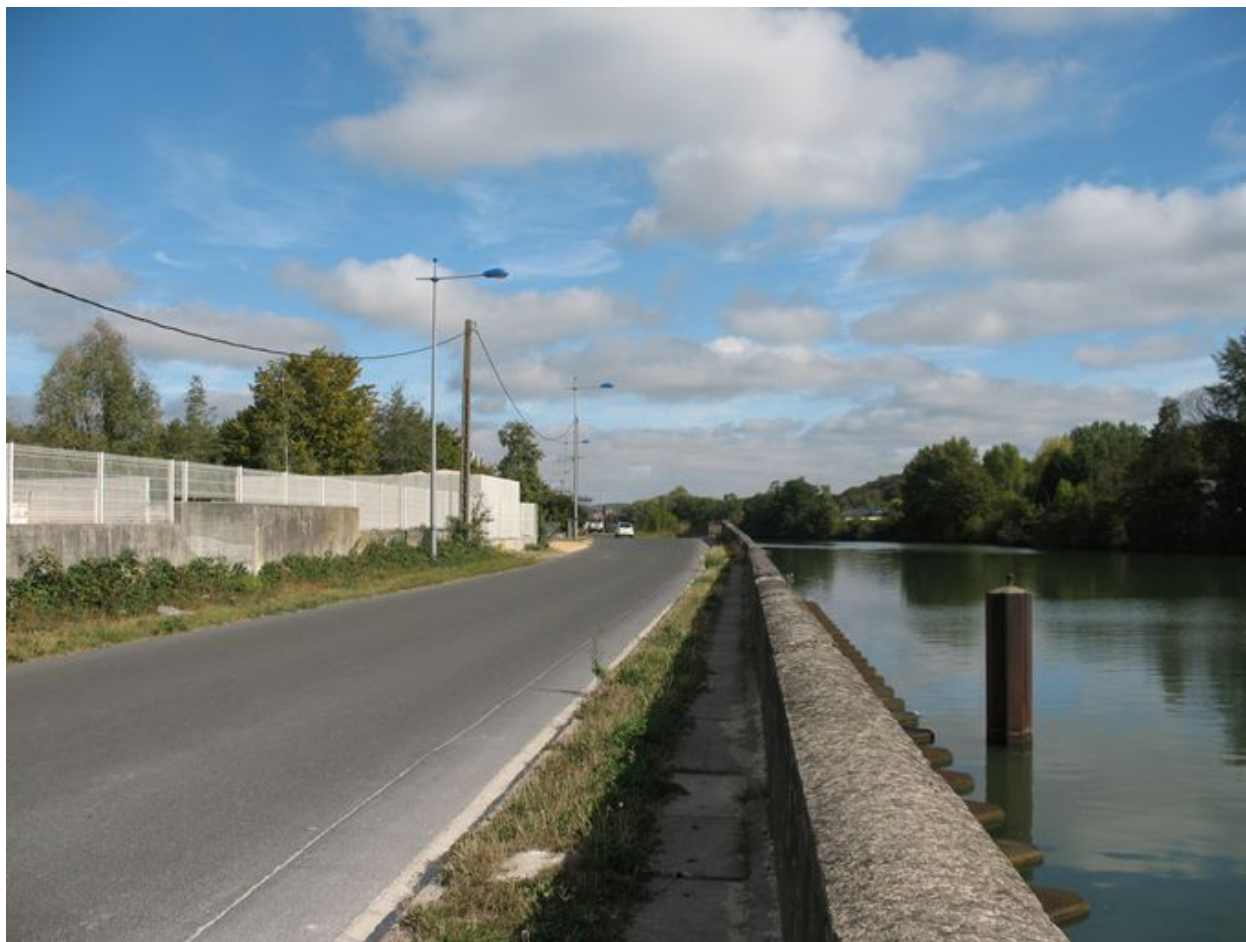
L'Oise, le quai d'Amont et l'ancien site de la tonnellerie.
