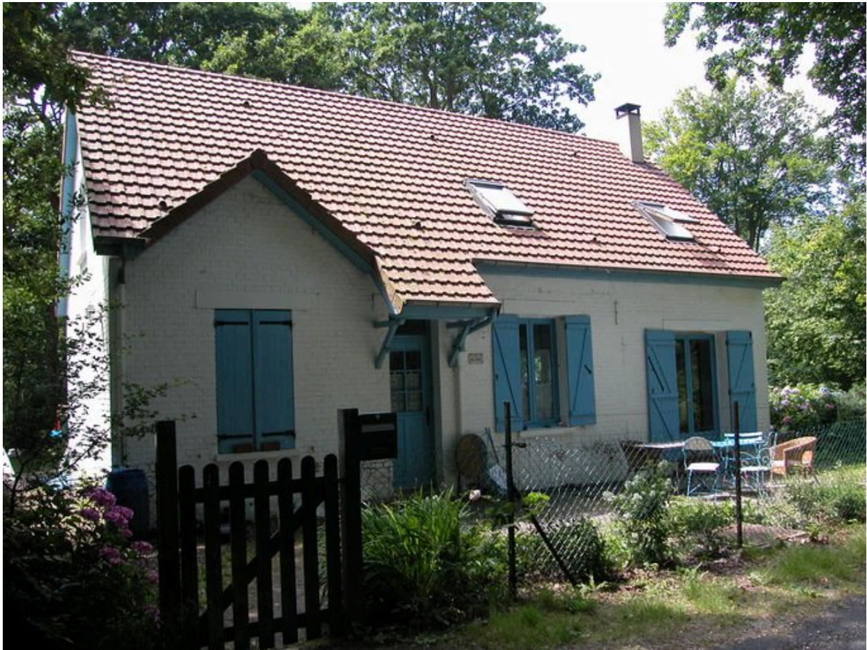
La Voix des Chênes, 2 route de la Mare aux Biches (1990 AL 46), reconstruite en 1951.
