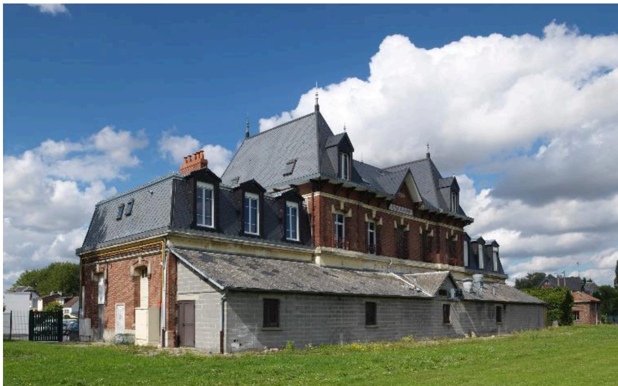
Vue des façades postérieures.
