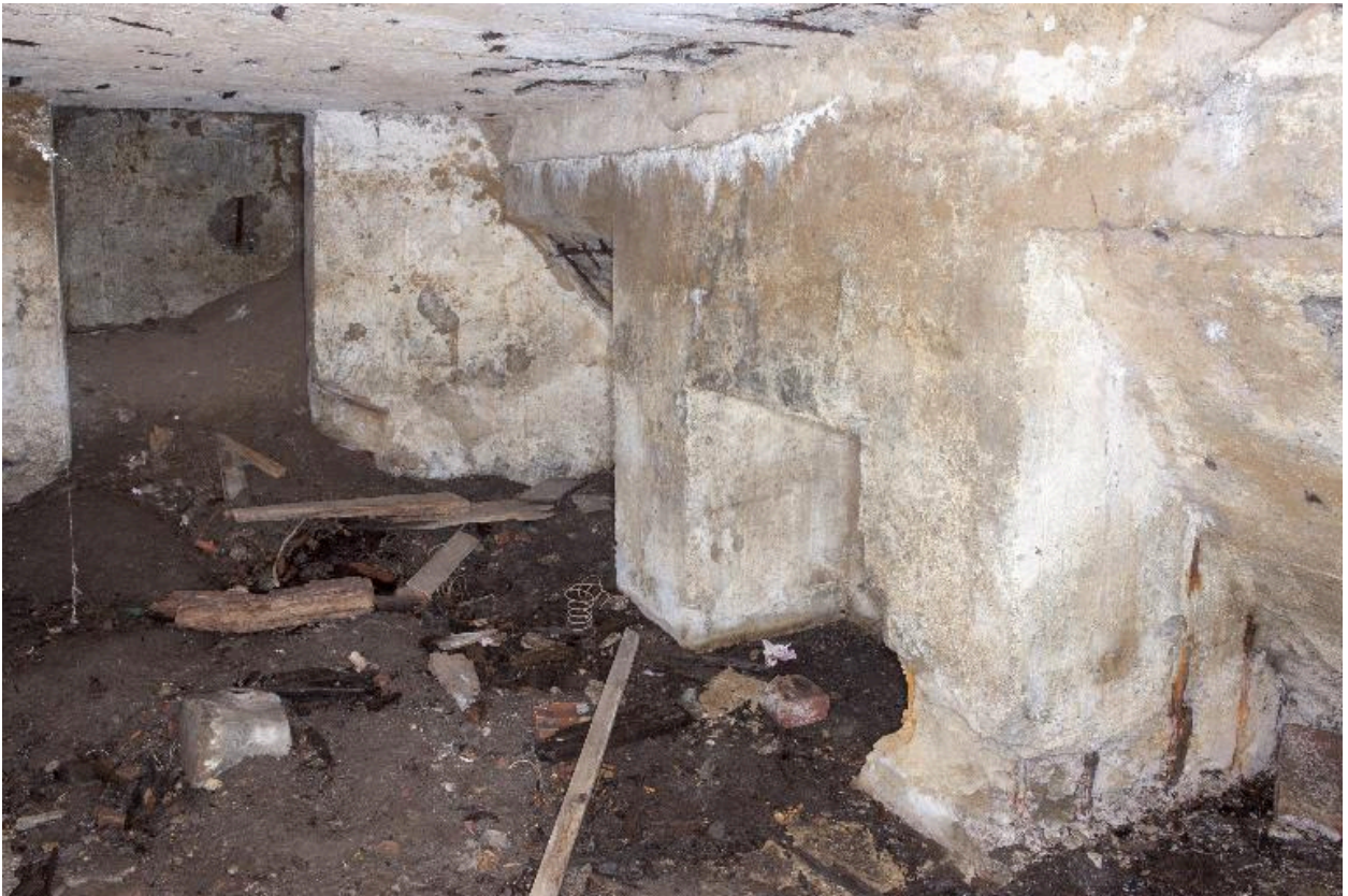
Casemate B : Vue intérieure, vers le sud
