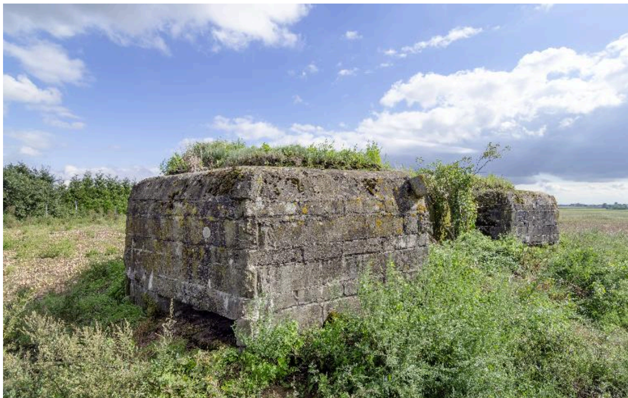
Vue de trois-quarts vers le sud-est
