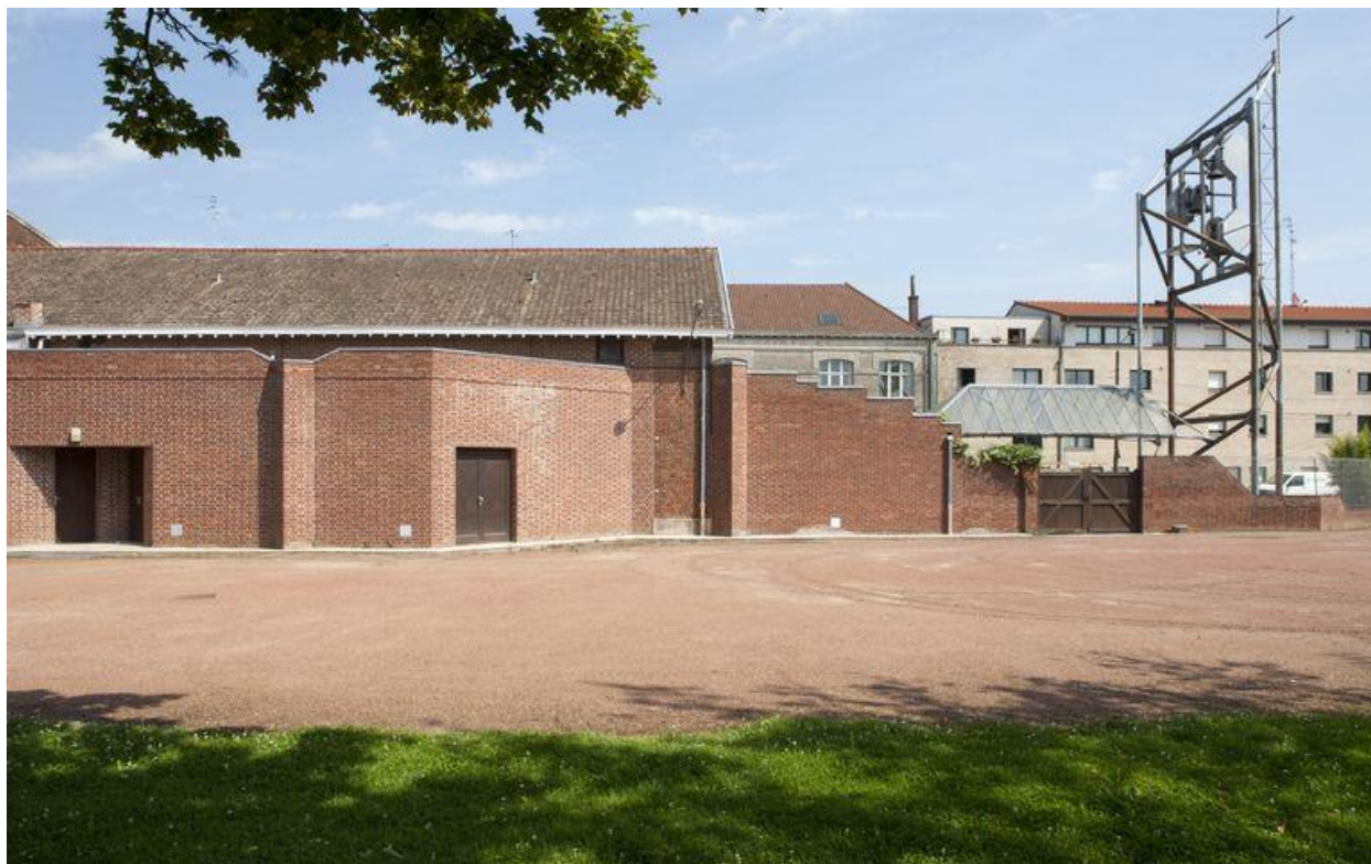
Façade côté sud et clocher.
