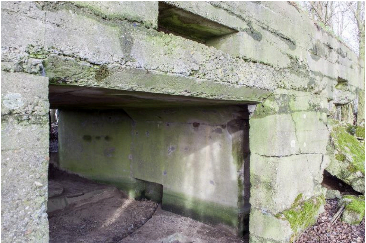
Elévation sud, détail de la cellule d'éclatement
