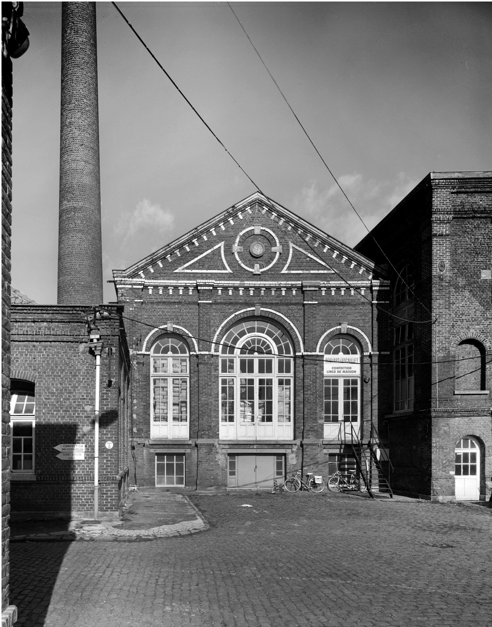
Seconde salle des machines. Élévation antérieure.
