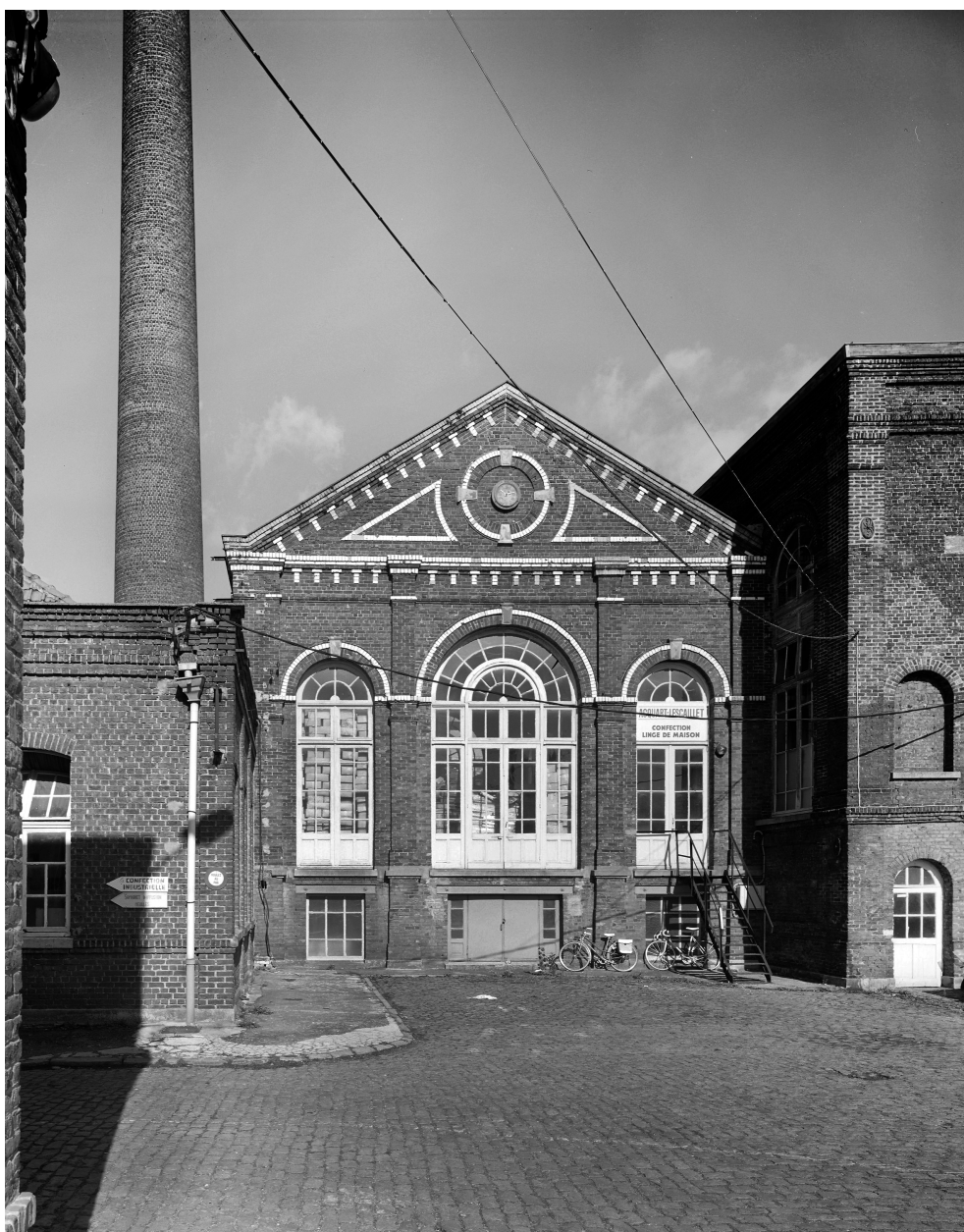
Seconde salle des machines. Élévation antérieure.
