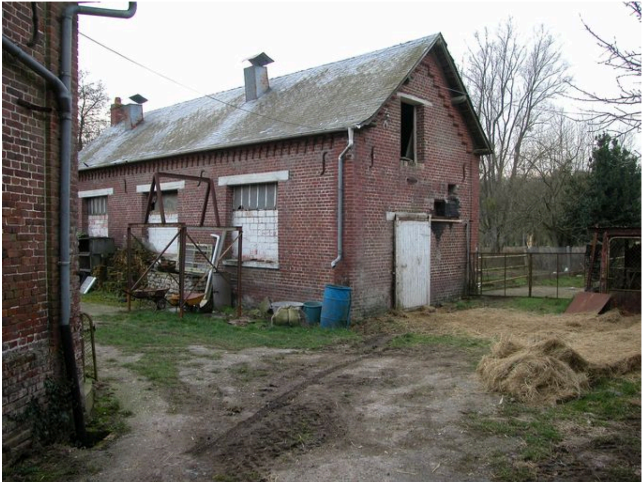
Atelier de montage, façade sur cour.
