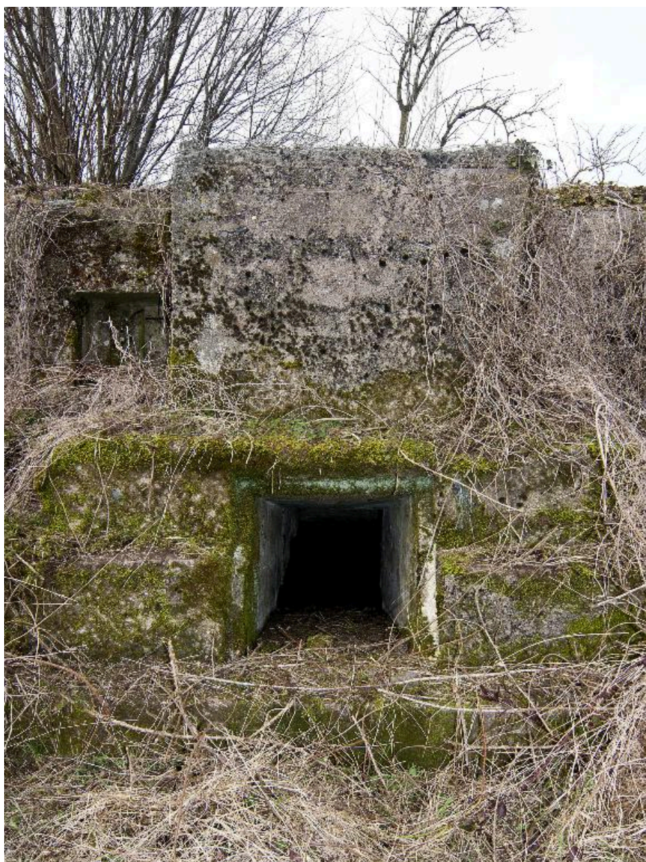
Resserre à mitrailleuse
