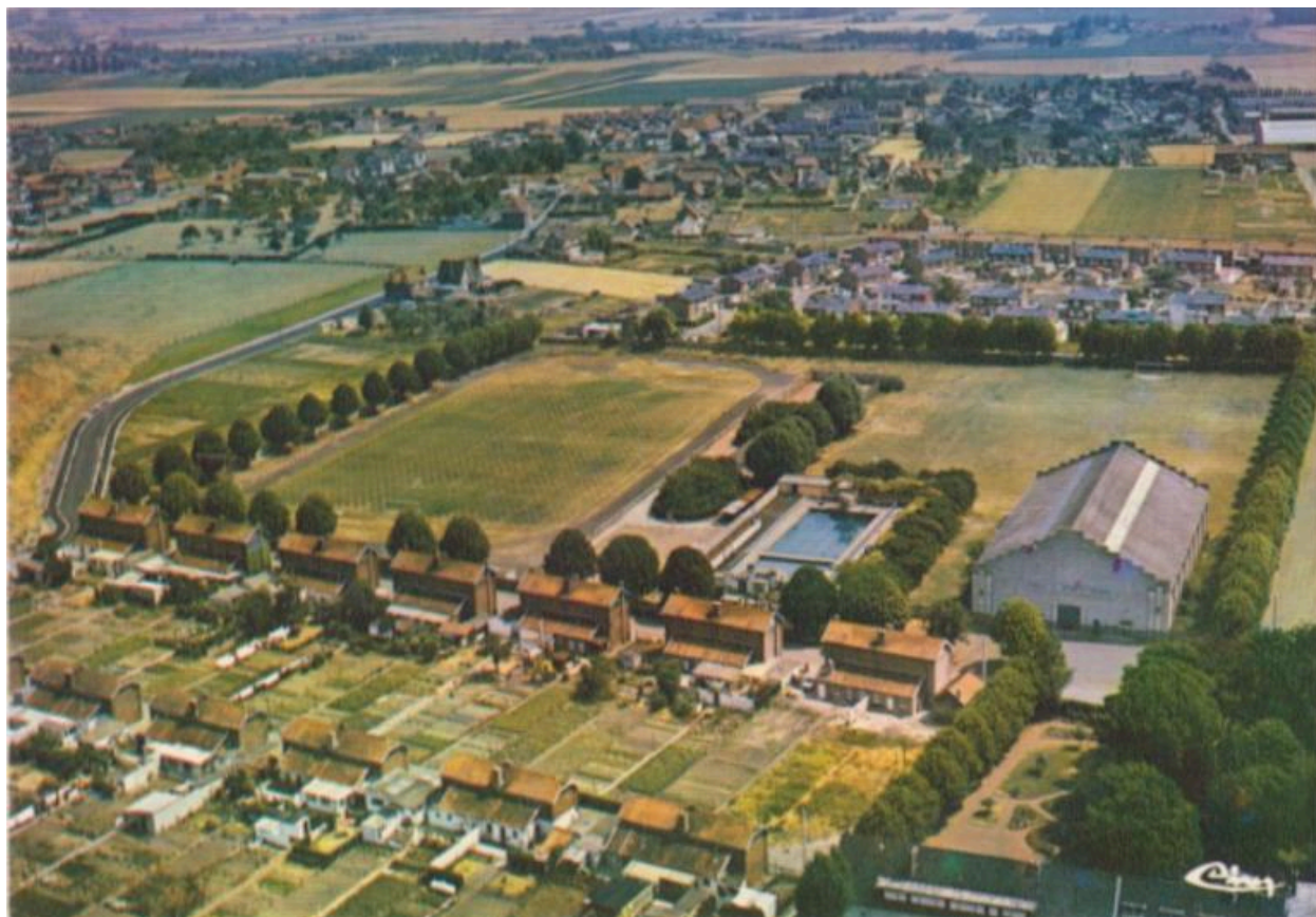
Vue aérienne de la piscine de l'usine Béghin à Thumeries, carte postale, vers 1960 (coll. part.).
