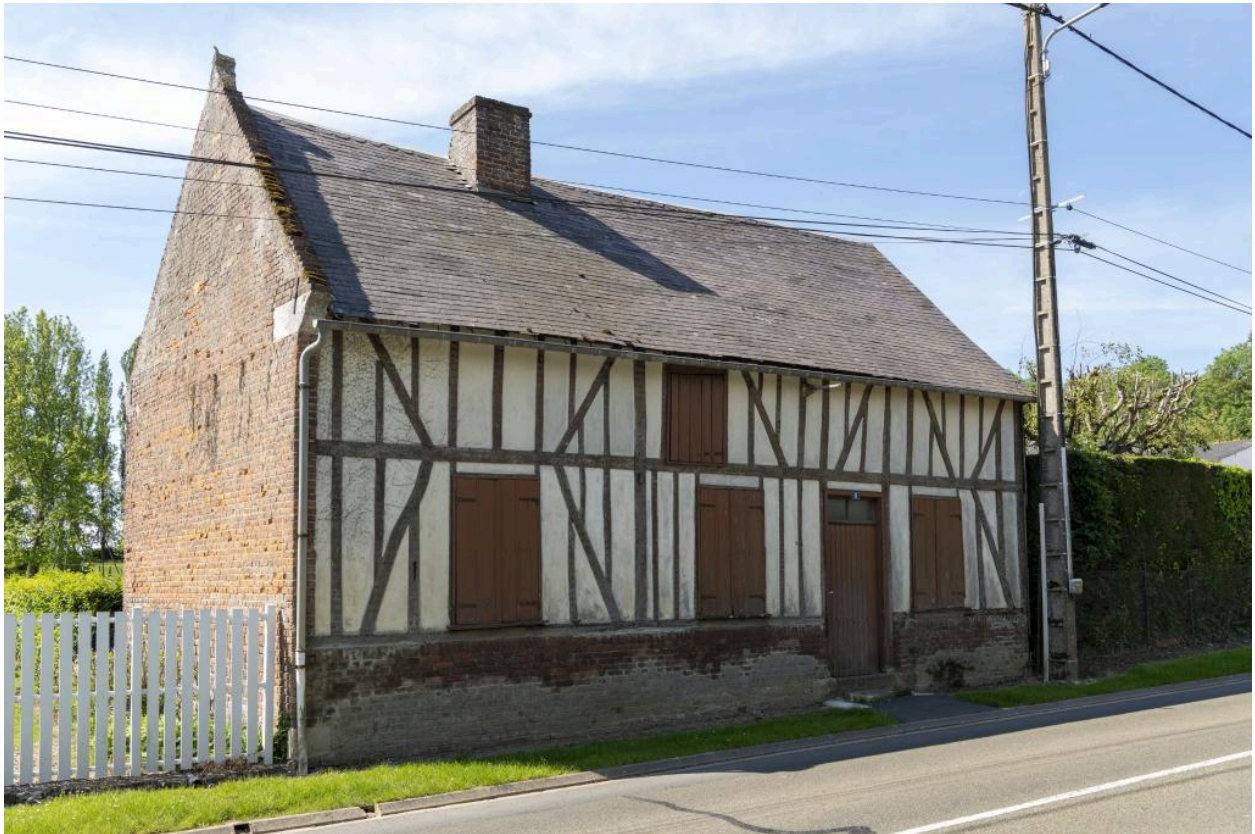
Logis sur rue avec comble, n°8 route de Rouen, vue depuis le nord-est.
