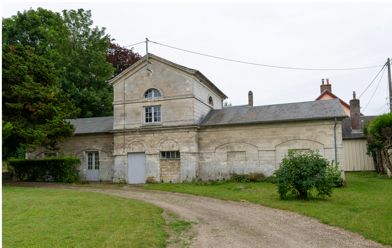
Dépendances côté sud, vue depuis le nord.
