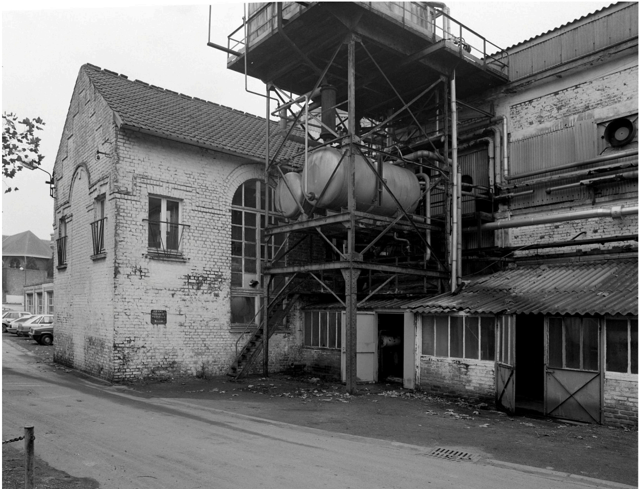
Ancienne salle des machines. Vue prise vers le nord-est.
