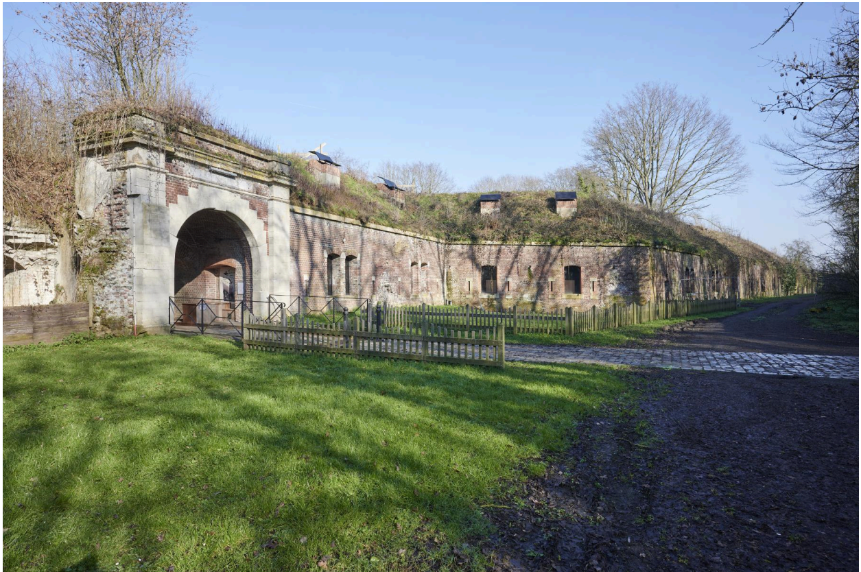
Front de gorge. Entrée du fort, casernes et créneaux de fusillade, vers l'est.
