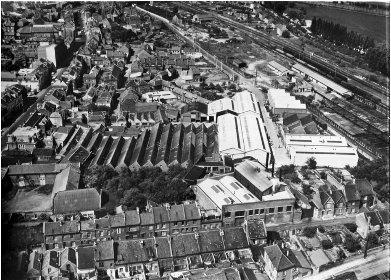
Vue aérienne en 1961-1962 (AD Aisne).
