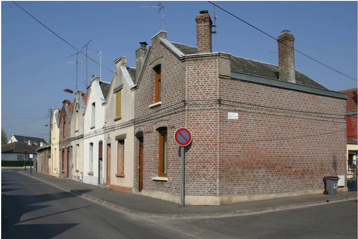
Groupe de six logements construits vers 1885.
