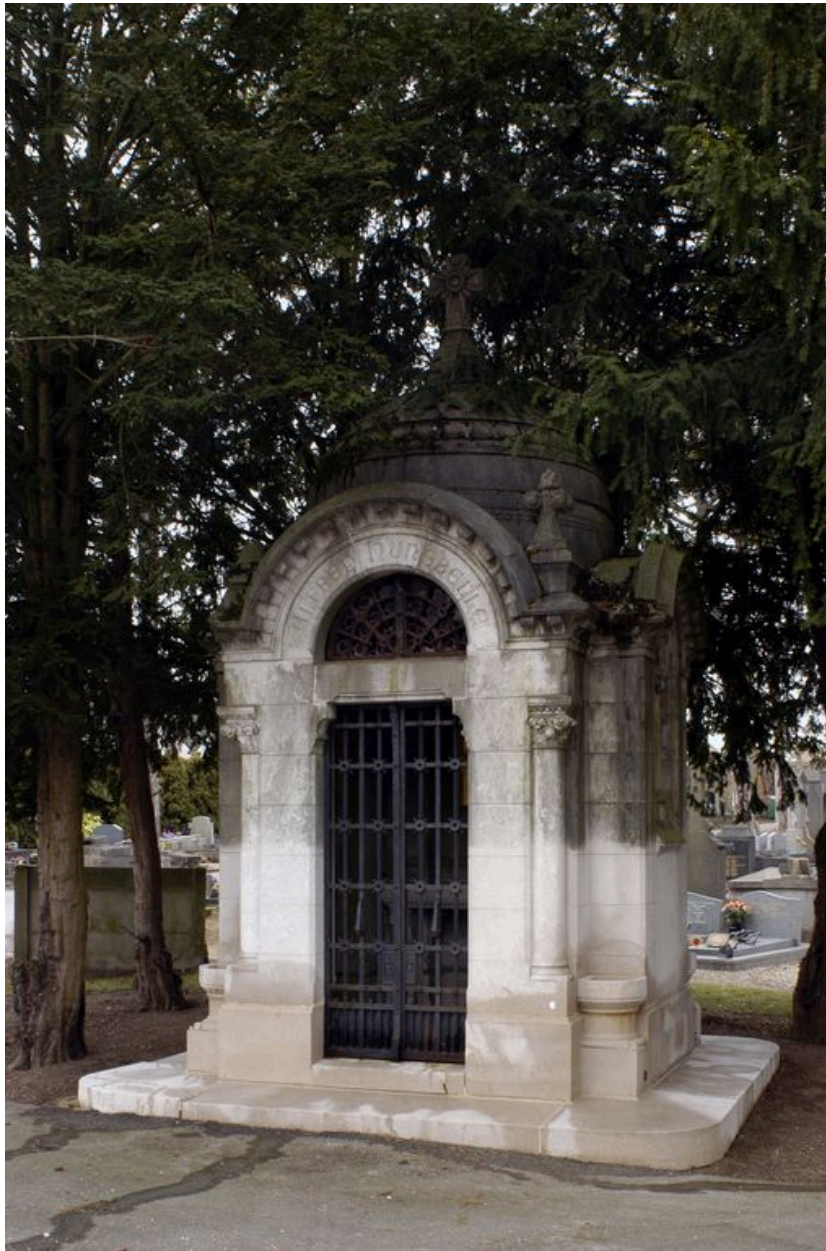
Tombeau (chapelle), 1908. Jérôme Rastoin (architecte). Amiens, Vieux Saint-Acheul.
