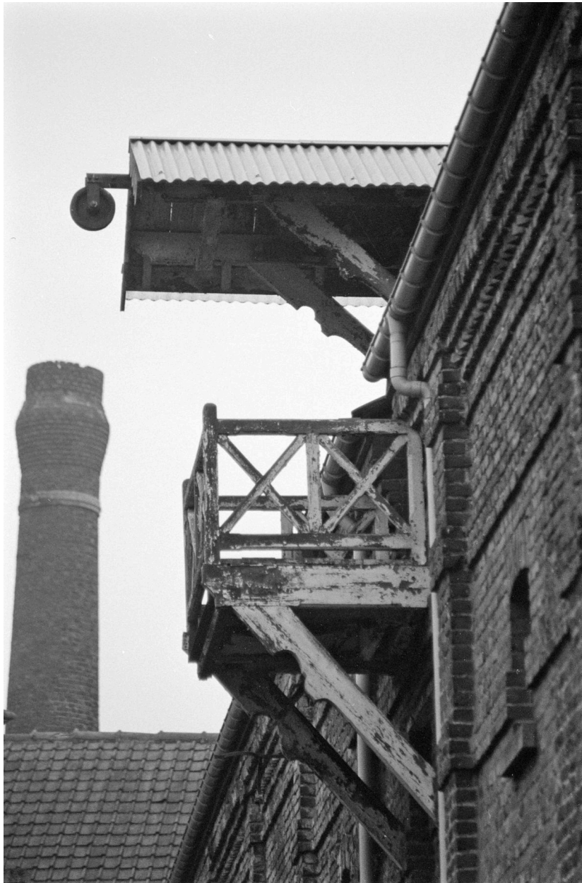
Monte-sacs de la malterie et cheminée.
