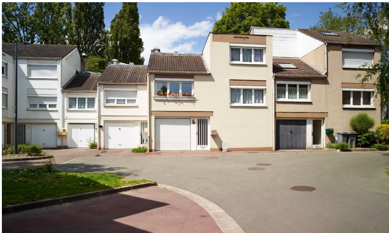
Placette au niveau du 169 allée Chardin.
