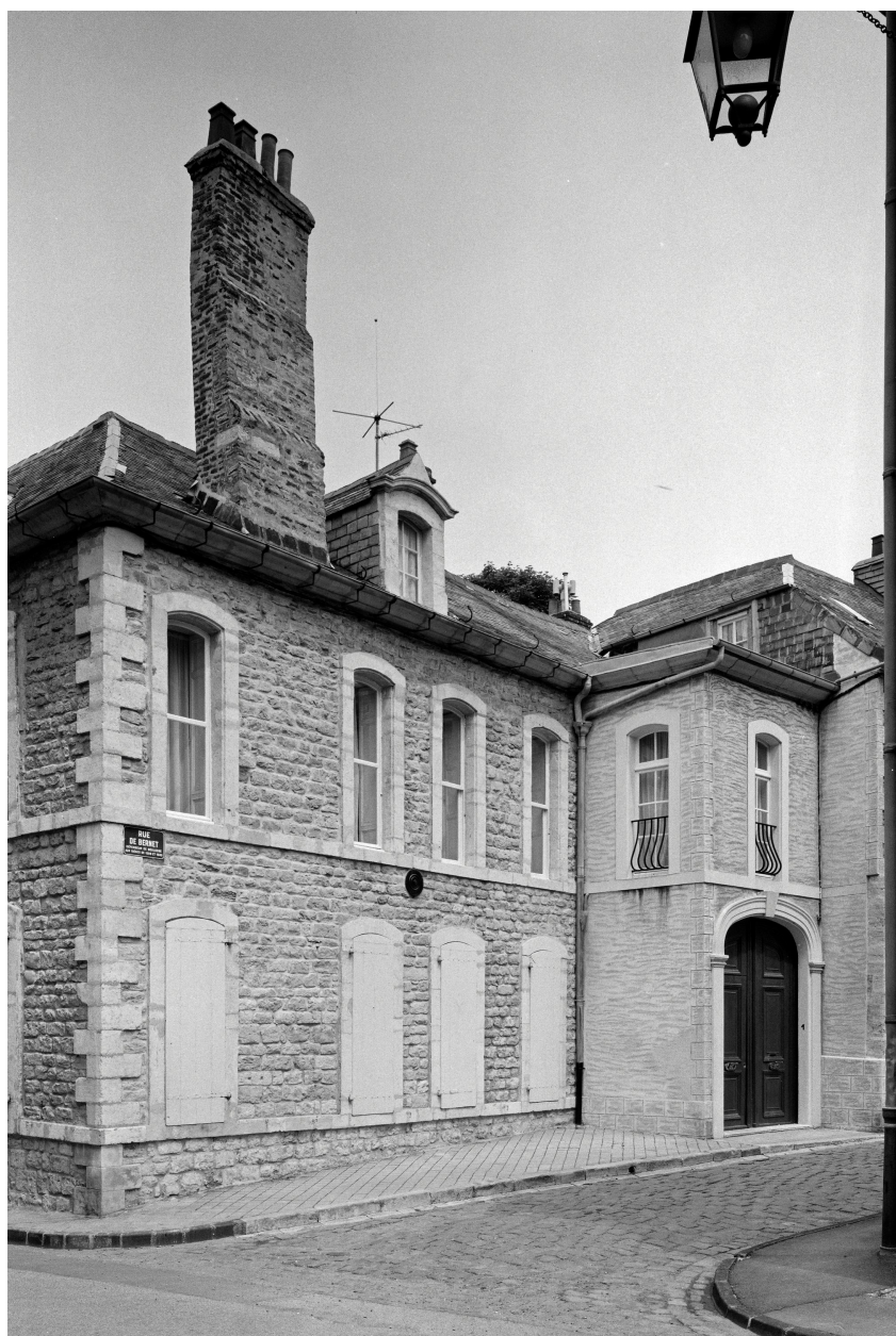
Vue de profil sur rue de Bernet.
