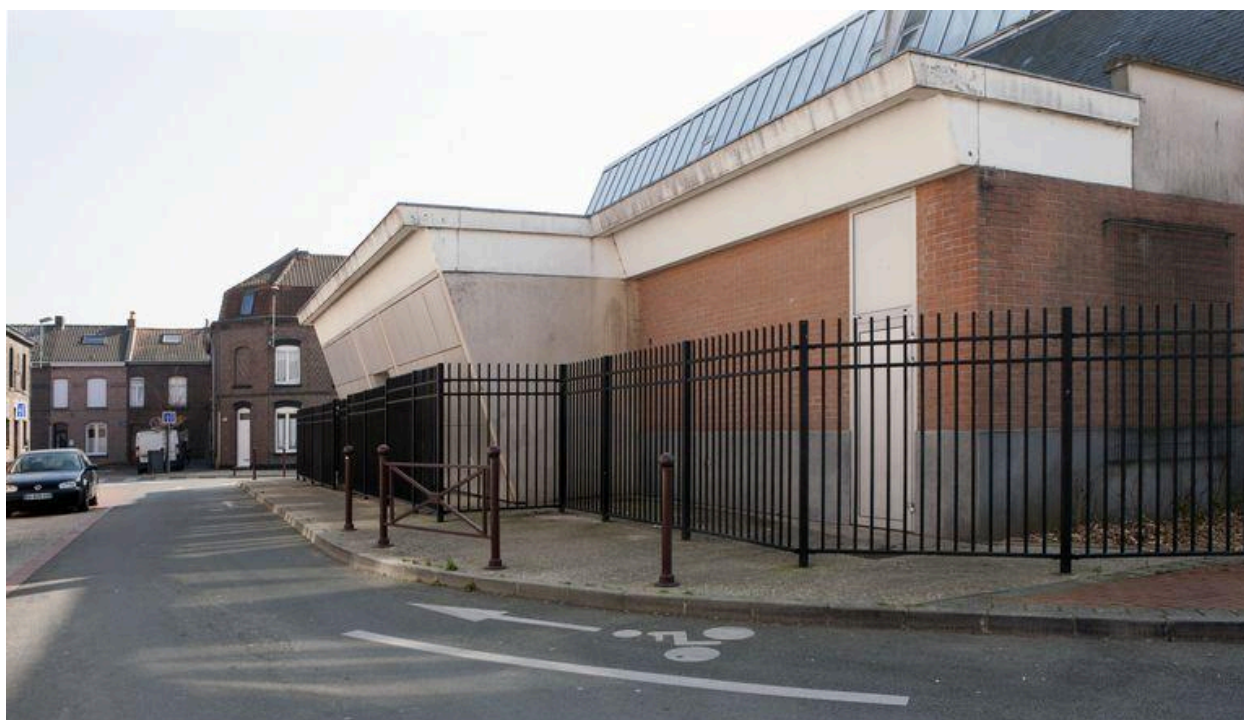
Flanc droit de l'église.
