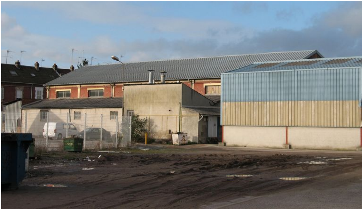
Façade sud de la salle des fêtes.
