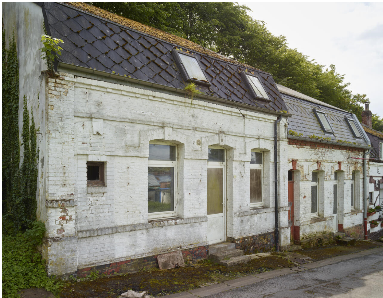
Trélon, cité ouvrière Rossette, puis Achille Falleur.
