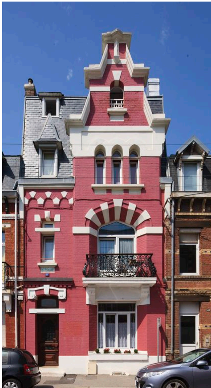
Maison de ville, 41 rue Rotschild, construite en tant que petit hôtel par l'architecte M. Montarnal.
