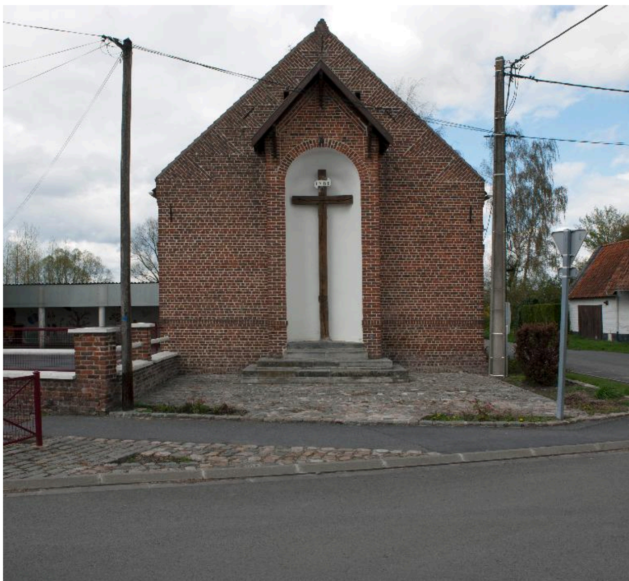
Vue générale du calvaire adossé à l'ancienne grange.
