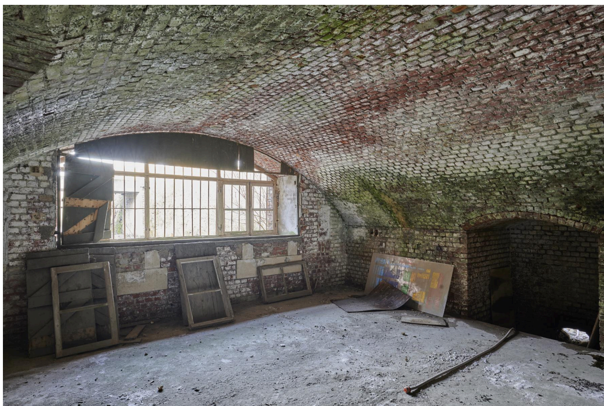
Sous-sol de caserne de gorge. Caserne de flanquement est.
