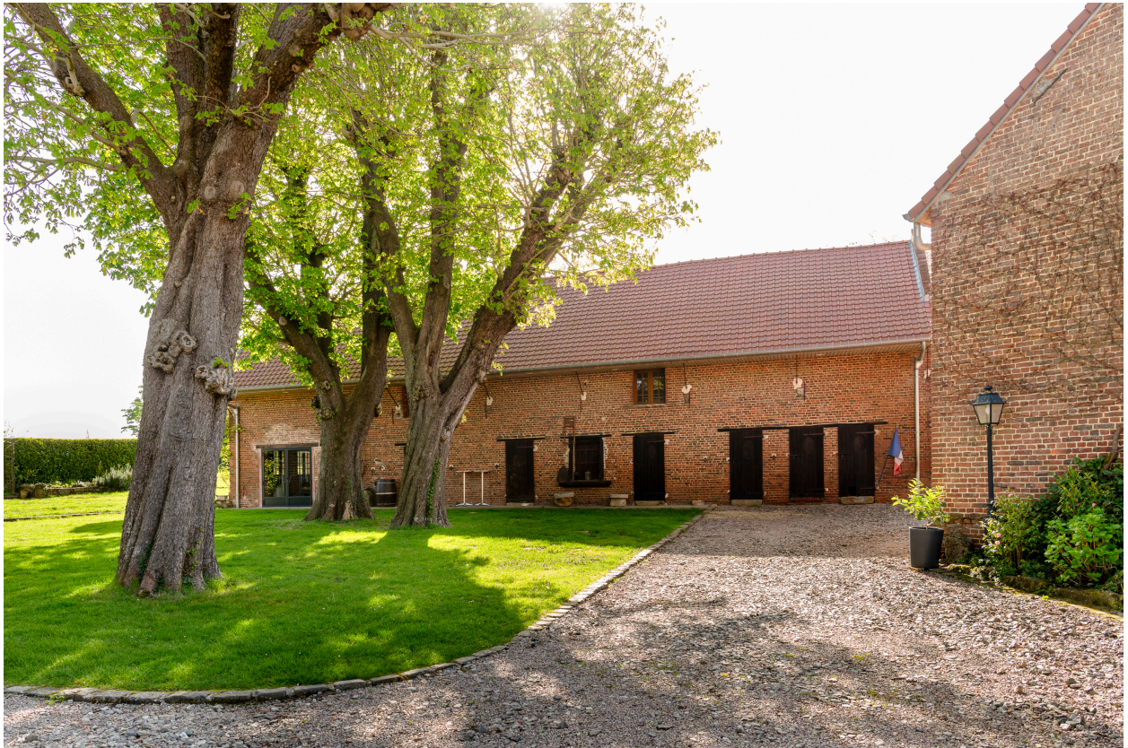
Anciennes écuries et étables, côté sud de la cour, n°7 de la Grande Rue.
