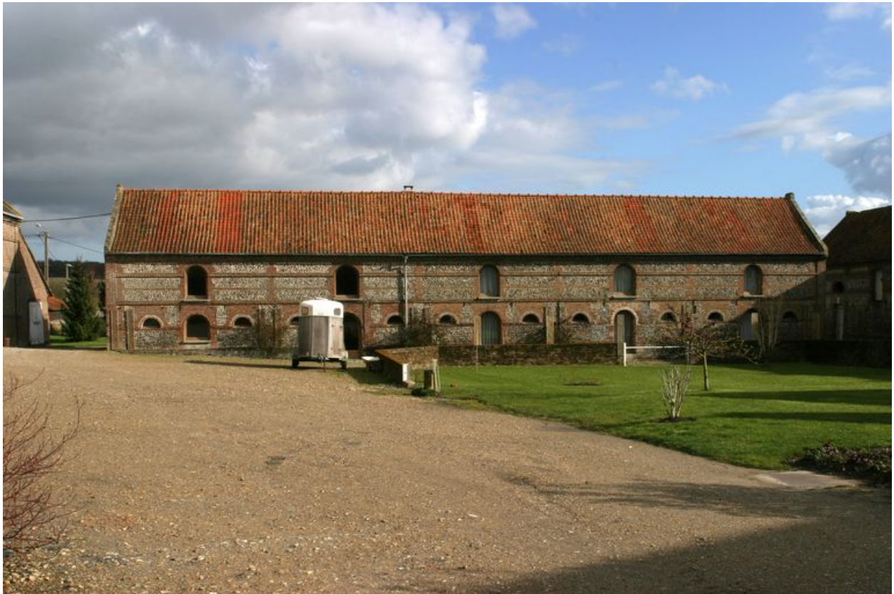
Vue de la vacherie et de la bergerie occupant tout le côté est de la cour.
