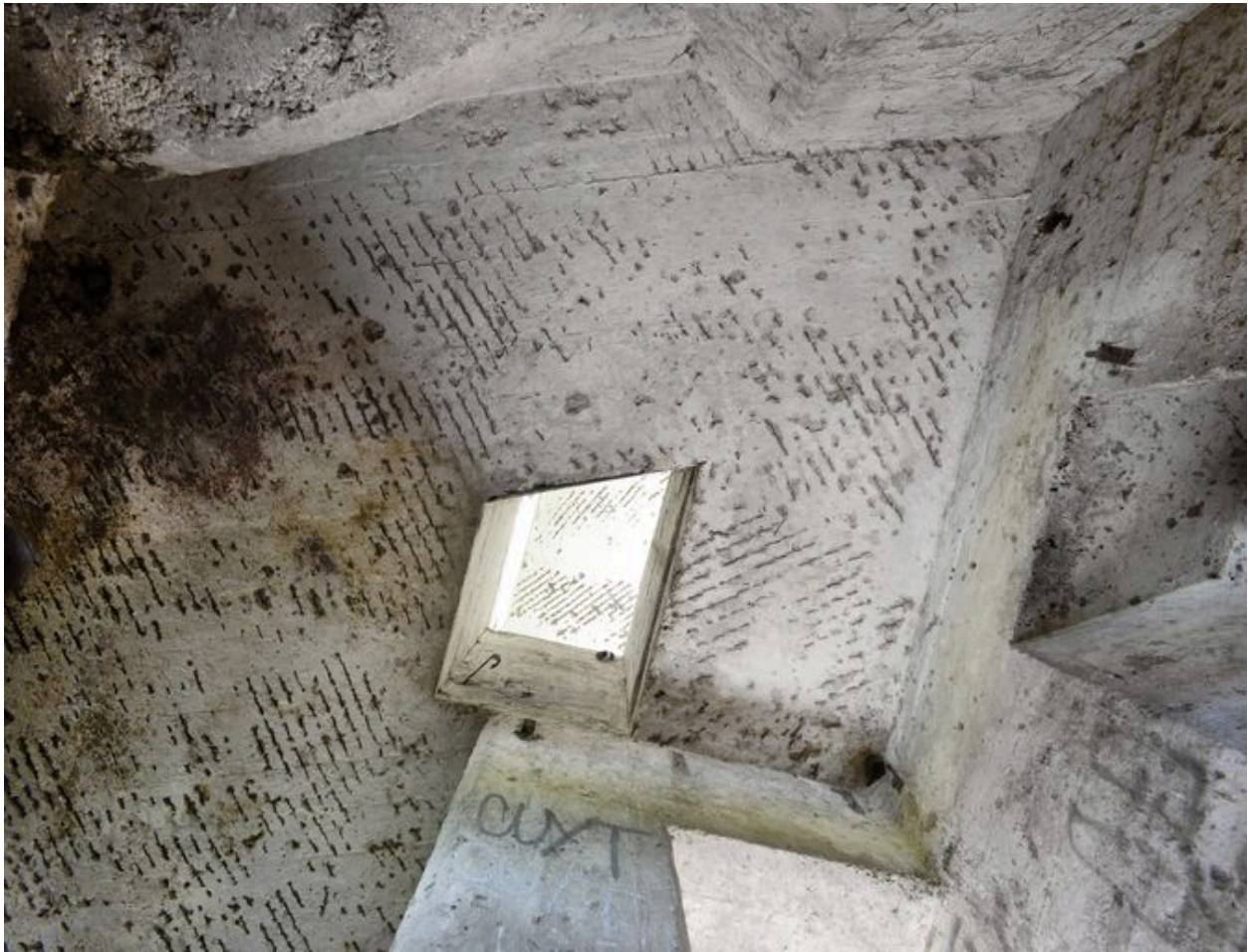
Vue zénithale de l'accès à l'étage (au grand-angulaire)
