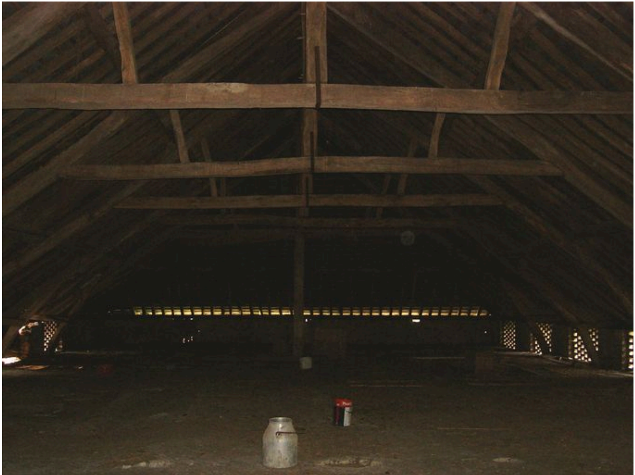
Vue intérieure du grenier, les aérations en damier permettant le séchage des récoltes.
